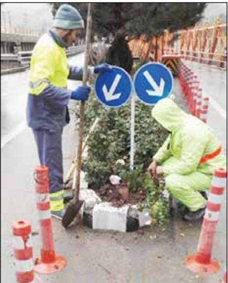
تعویض تابلو ها و لکه گیری آسفالت
